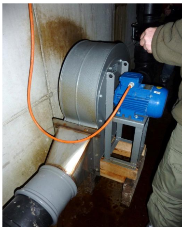
En af de to 2,2 kW blæsere som belufter den 100 meter lange stald. Fordeling af indblæsningsluften til 8 rør. Hver blæser forsyner 4 rør.
